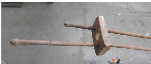
Cabeza recalcada enhebrada en barra metálica. Sistema pretensado
