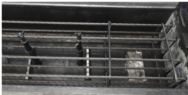
Acero trenzado para durmiente de aparato de vía.
