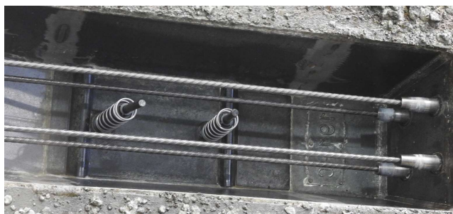
Acero espiralado, adherencia mejorada.
